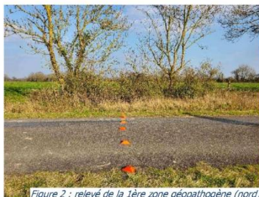
Figure 2 : relevé de la 1ère zone géopathogène (nord)
